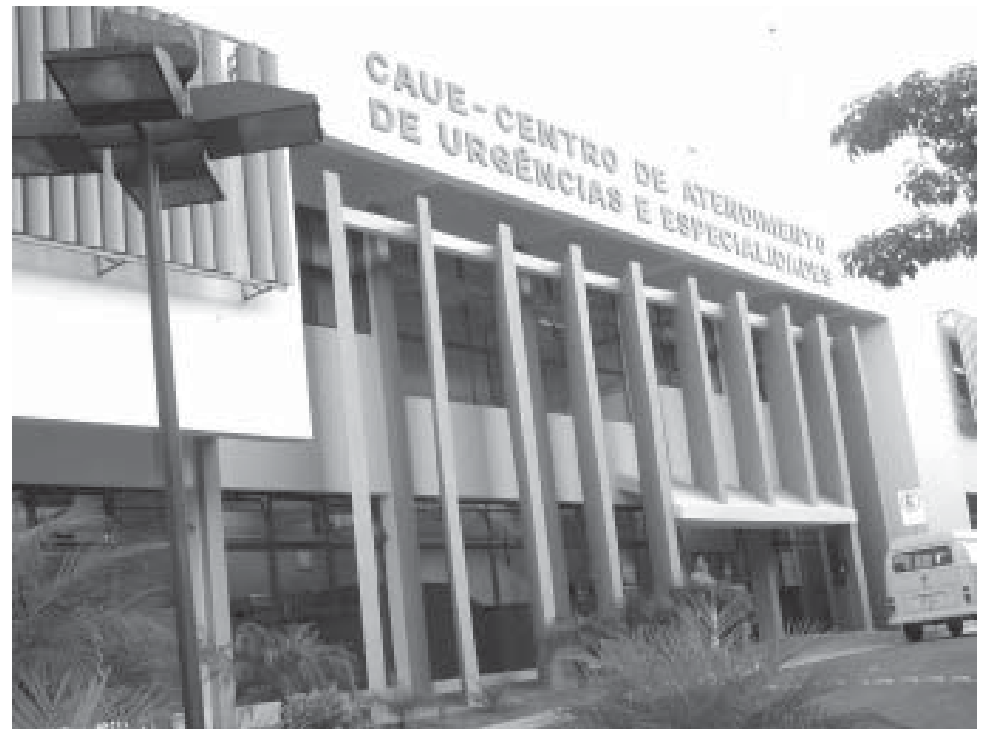
Centro Cirúrgico ficará instalado no pavimento superior do CAUE
