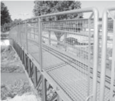
Passarela: mais segurança à travessia
