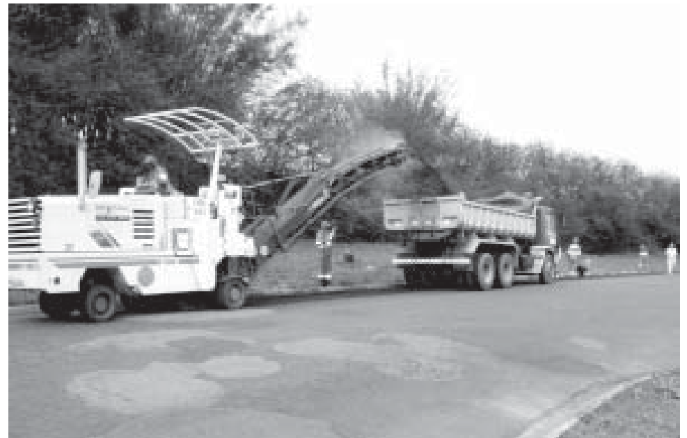
Máquina realiza raspagem da antiga capa asfáltica na Av. Campos Salles
