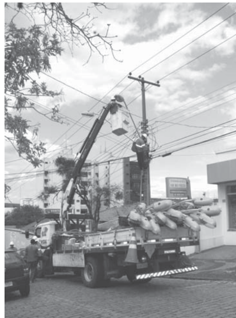
Troca de iluminação na Rua Itália
