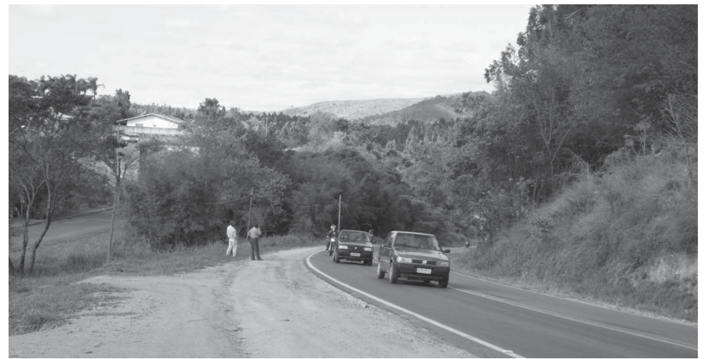
Trecho na Rodovia dos Agricultores que receberá a terceira faixa
