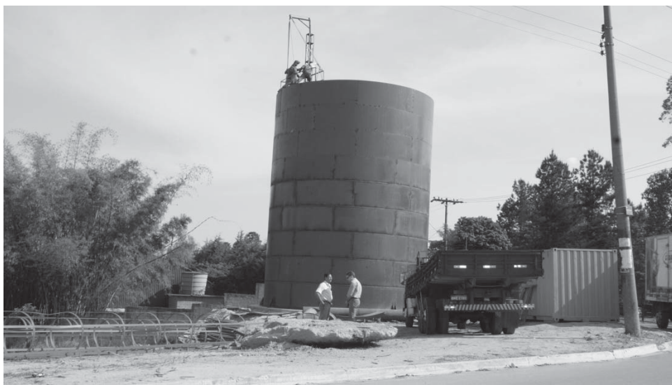
Instalação de chaparia no reservatório é feita manualmente
