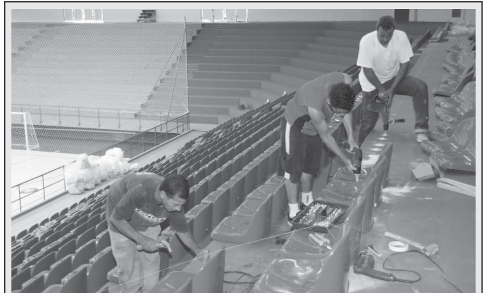
Ao todo estão sendo instaladas 3.550 cadeiras nas arquibancadas
