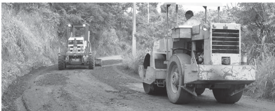
Trecho de terra da Av. Rosa Belmiro Ramos recebe pavimento rural
