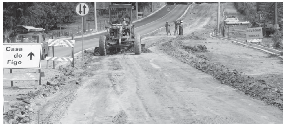
Obra na Estrada do Jequitibá em fase de terraplenagem da nova pista
