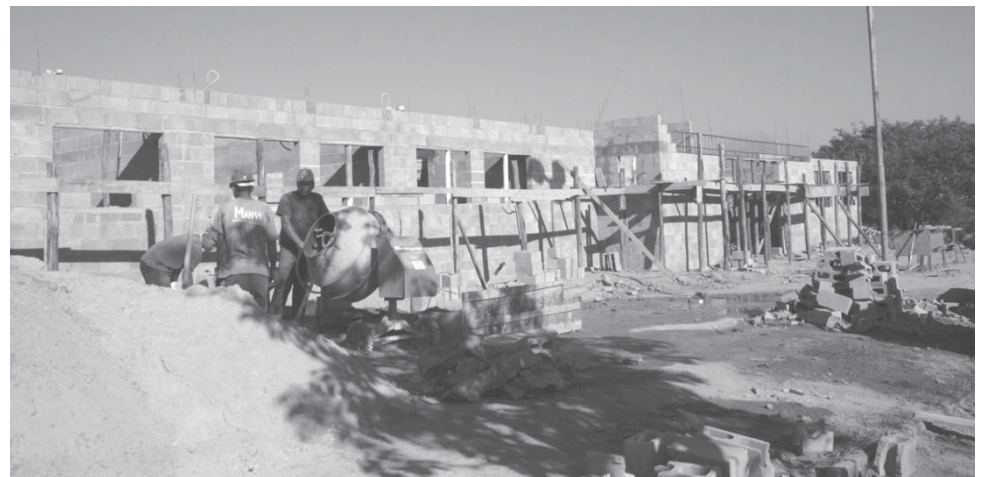
Obras do Pronto Atendimento de Saúde no Jardim Paraíso
