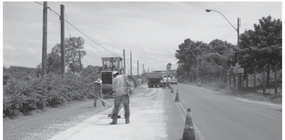
Obras de recapeamento na Rod. dos Andradas que terá iluminação melhorada
