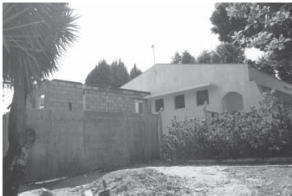
As obras na UBS do Jardim Imperial estão em fase de levantamento de paredes
