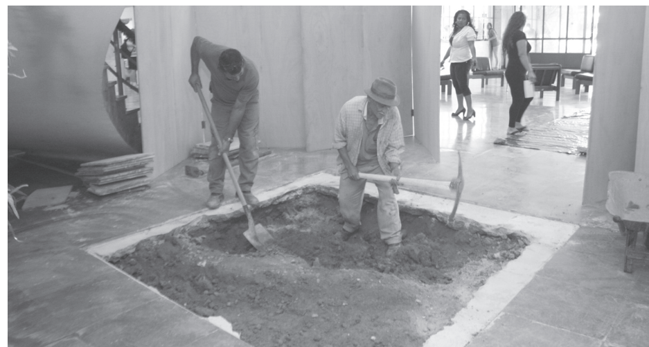
Elevador a ser instalado comportará até três pessoas
