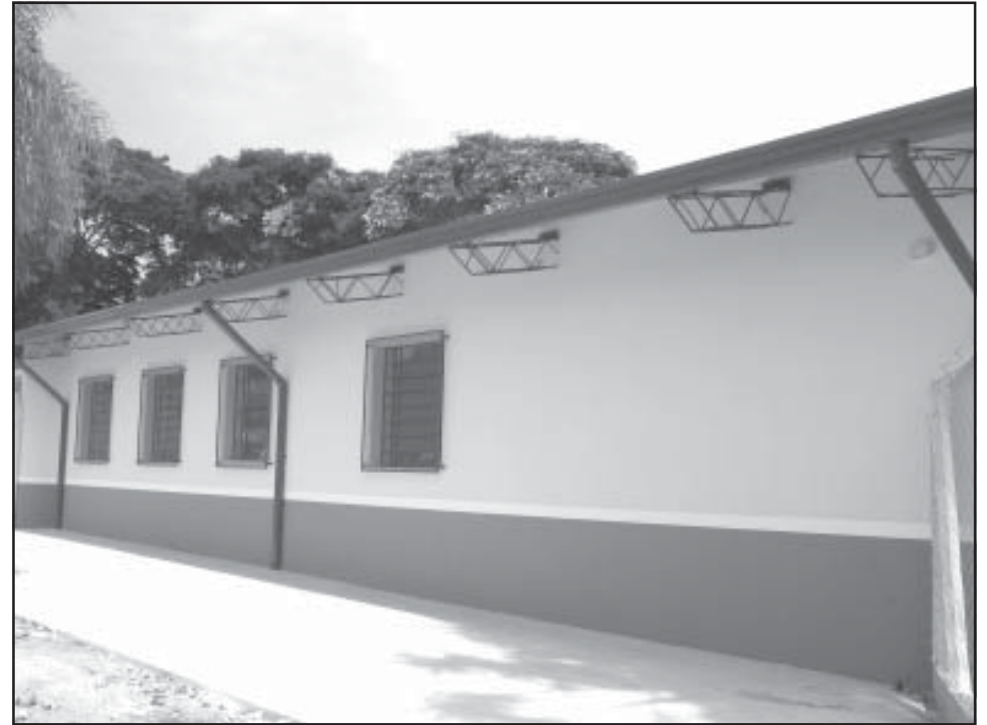
EMEI "Angela Turcatti" passou por reforma completa e ampliação
