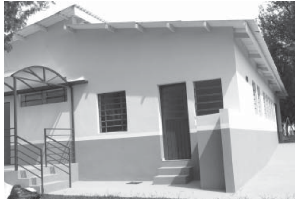
EMEI do Jardim Imperial ganha novo visual após as obras
